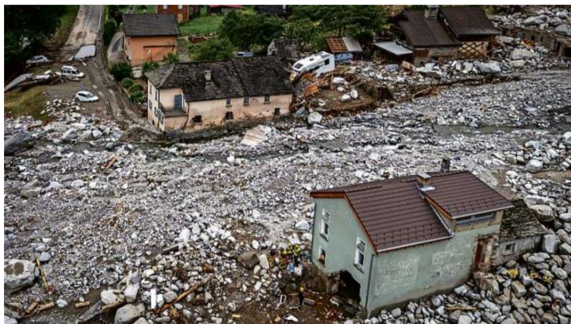
Grosses Leid: Eine Aufnahme vom 25. Juni zeigt das Ausmass der Zerstörung in Sorte.
