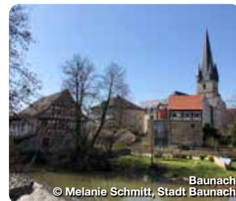
Alte Baunachbrücke © Quelle: Stadt Baunach
