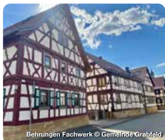
Behrungen Fachwerk © Gemeinde Grabfeld
