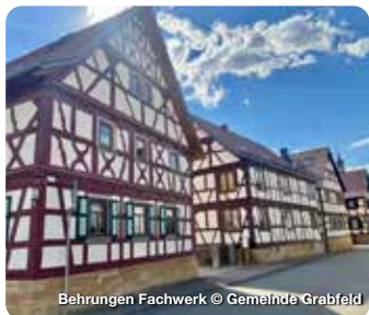
Behrungen Fachwerk © Gemeinde Grabfeld
