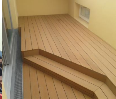
Decklage mit Stufenanlage
