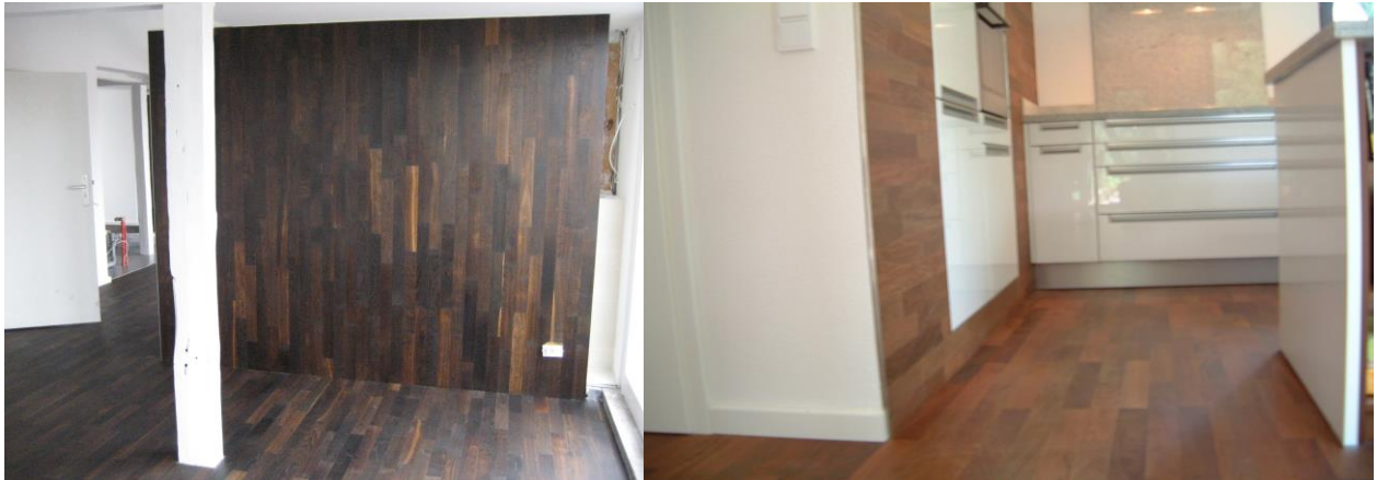
Parkett fortlaufend Boden /Wand mit Integration Einbauküche in der Wand montiert
