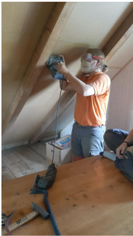
Jonas Melcher beim Schleifen im neuen Dachstock...
