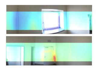
Für unsere Thermalanalyse nutzen die Infrarot-Bilddaten 360° von unserer -Thermografiekamera, um Hinweise auf Probleme in der Bausubstanz liefern. zu macht Handlungsbedarf auf einen Blick sichtbar und hebt mögliche Problembereiche wie z. B. Wärmebrücken, Wasserrohrbrüche oder feuchte Stellen hervor.
