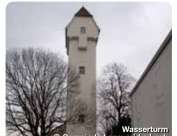
Wasserturm © Gemeinde Langweid a.Lech
